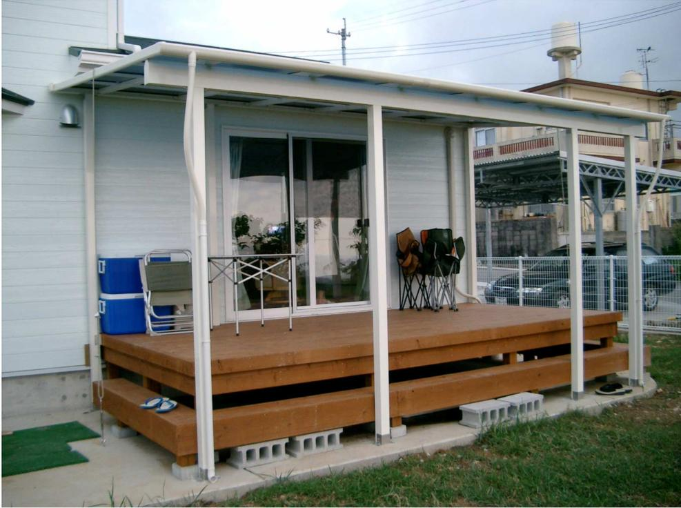
S邸アルミテラス工事（西日対策の為熱線カットのルーフパネル使用）
